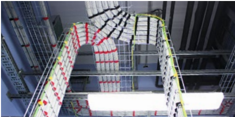
Installation correcte des colonnes montantes verticales
