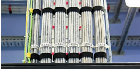
Fixation correcte des câbles verticaux
